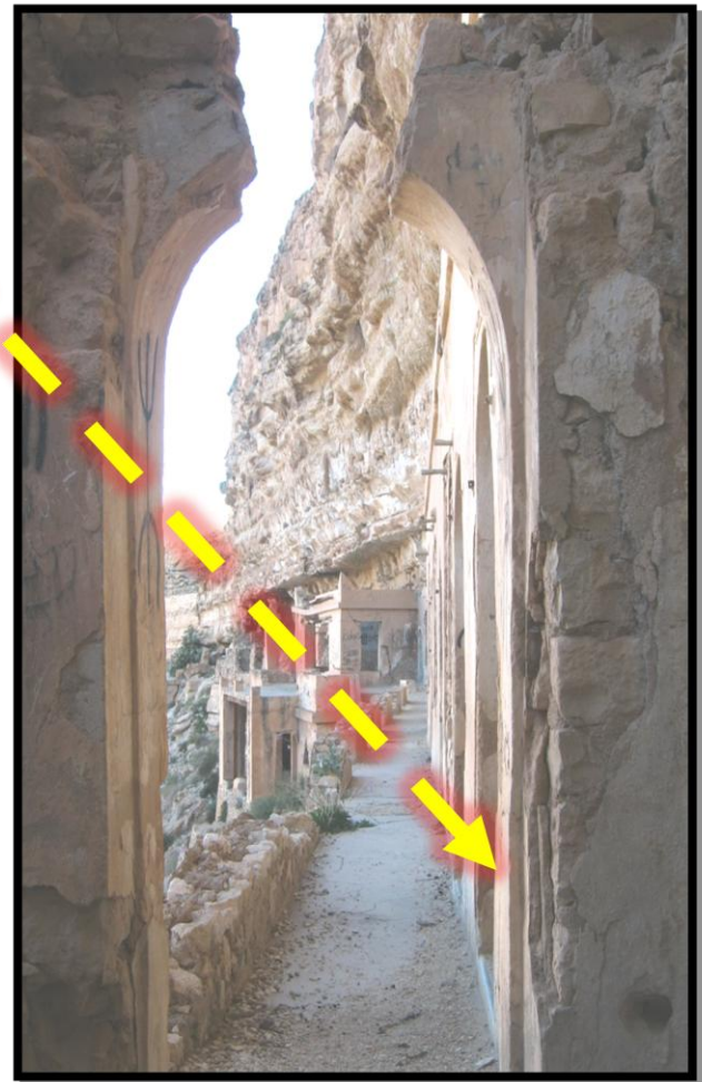
Vue sur la coursive desservant les chambres de l'hôtel
